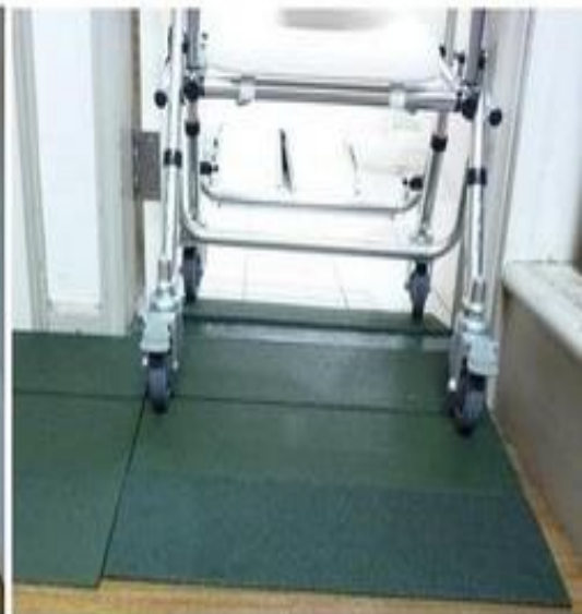
出入口加寬 + 高低差改善 雙扇運動門 + 活動式斜坡磚
